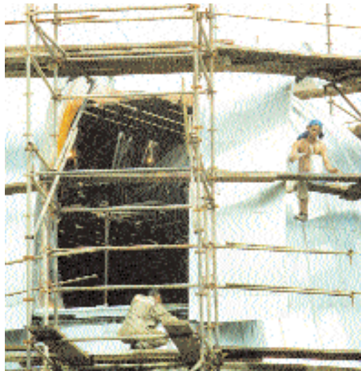
Figuras 7d – Cúpula após pintura, no processo de desmontagem dos andaimes externos (Mast, Arquivo Iconográfico, fotos Durval C. Reis).
