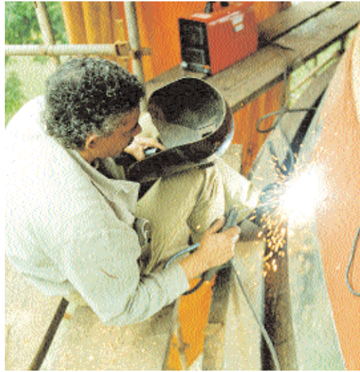
Figuras 7b – Soldagem de tira de alumínio à saia da cúpula para evitar infiltração de águas pluviais.
