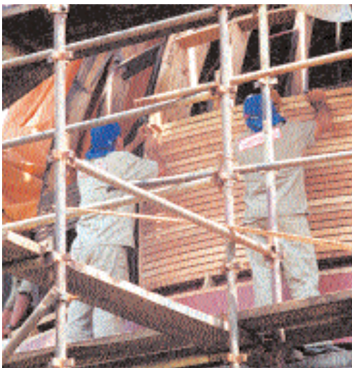
Figuras 7c – Substituição das fasquias de madeira existentes por outras em cedro.
