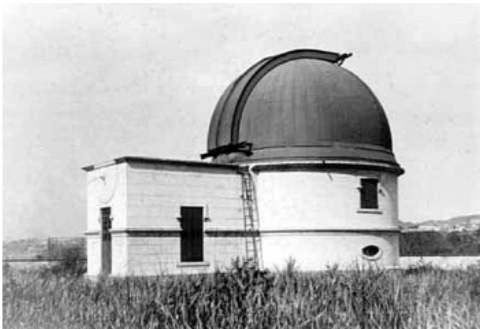
Figura 3 – Pavilhão da Luneta Equatorial de 32 cm após sua construção, 1920 (MAST, Arquivo Iconográfico, autor desconhecido).
