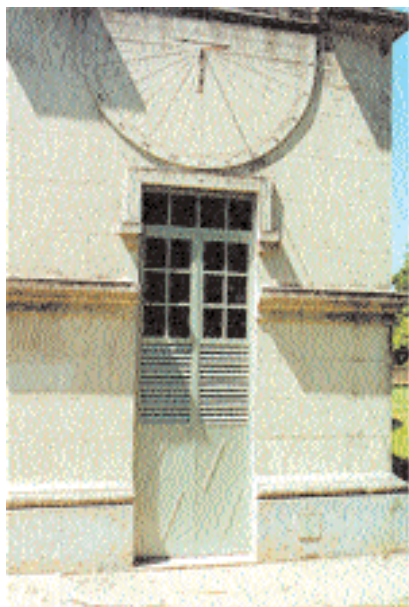
Figuras 6c – Nova esquadria (porta) instalada.
