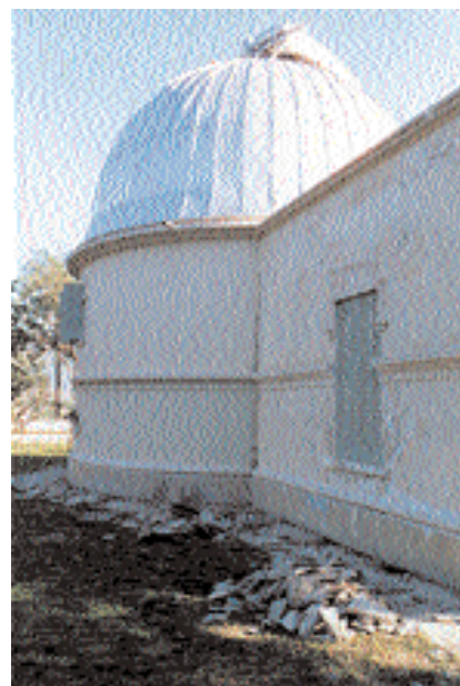
Figura 6b – Demolição do calçamento.
