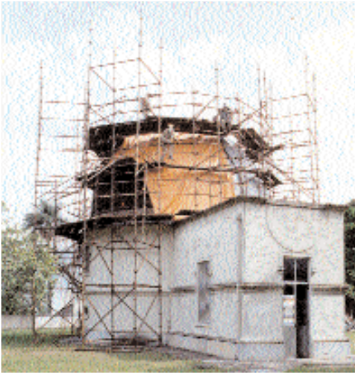
Figuras 7a – Montagem dos andaimes na parte externa do pavilhão.
