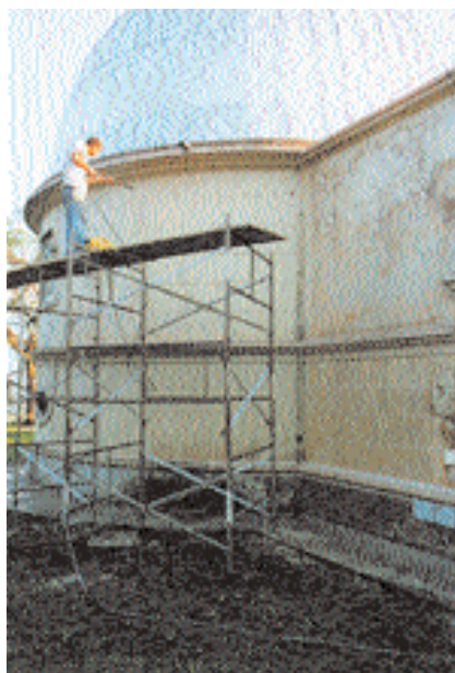
Figura 6a – Lavagem das alvenarias.
